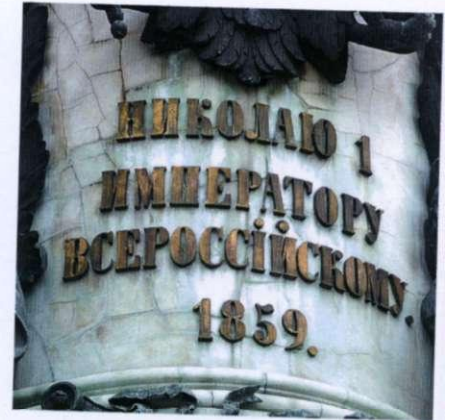
Рис. 3. Характер трещин и позеление мрамора: 87 трещин, S зел. -67% Изел.~0,5.
